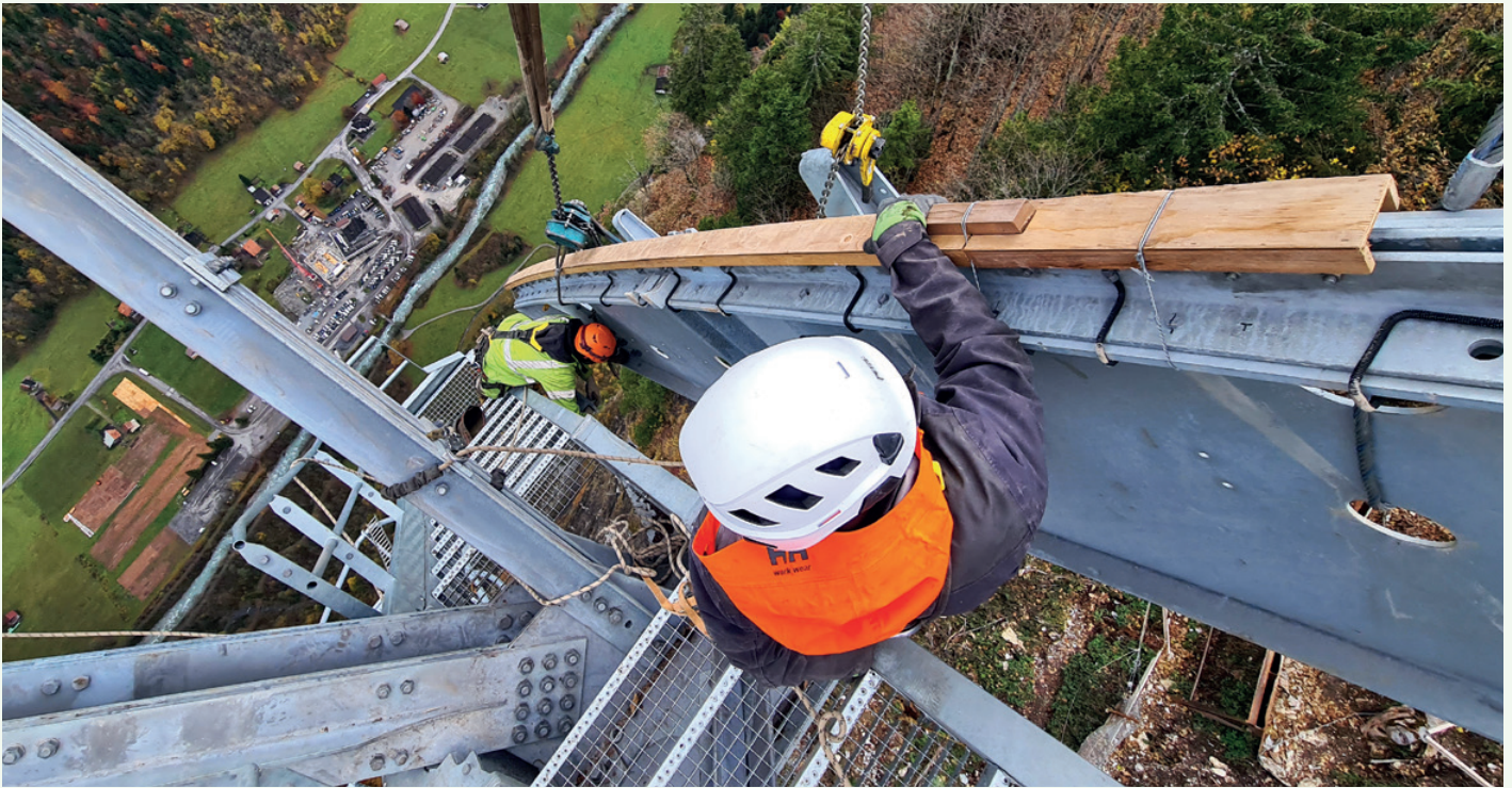
Montage Stütze 1 (Foto 16.11.2023 / Bruno Petroni)
